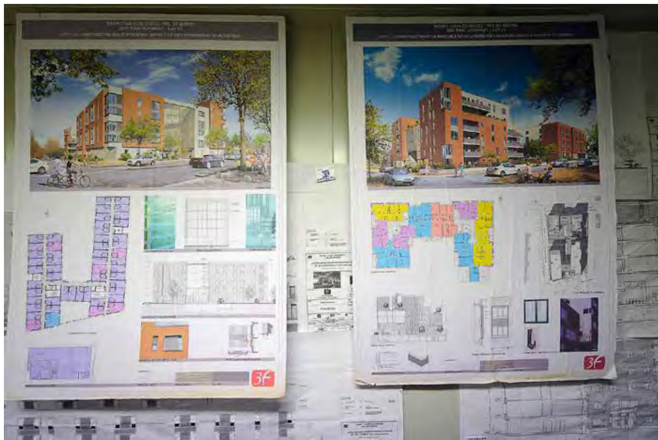
Chantier de construction de logements sociaux à L'Hay-les-Roses, 2013 © A. Bouissou / Terra
