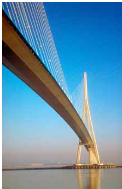
Pont de Normandie achevé en 1995
