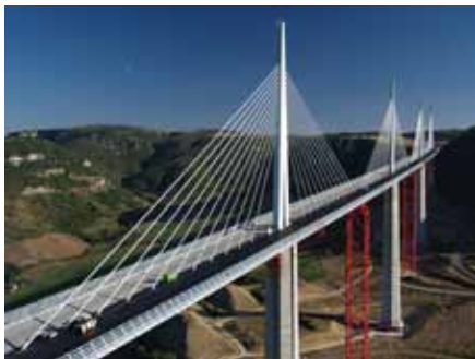
Viaduc de Millau en cours d'achèvement : plus qu'un pont à péage un prodigieux ouvrage de génie civil
