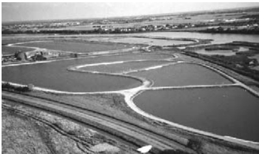
Station de lagunage de Rochefort (Charente-maritime), sept. 2000 phot. BDC H. Henri
