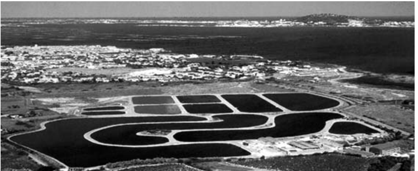
Les bassins de la station de lagunage de Mèze (Hérault), en bordure de l'étang de Thau. phot. ville de Mèze (34)
