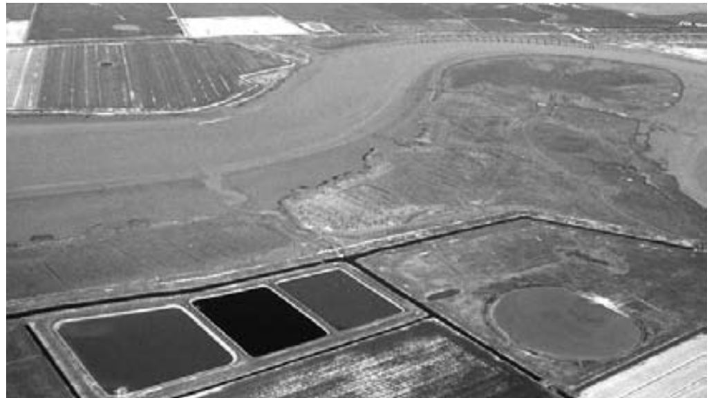
Lagunage et rejet dans la Sèvre de la station d'épuration de Charron (17).
