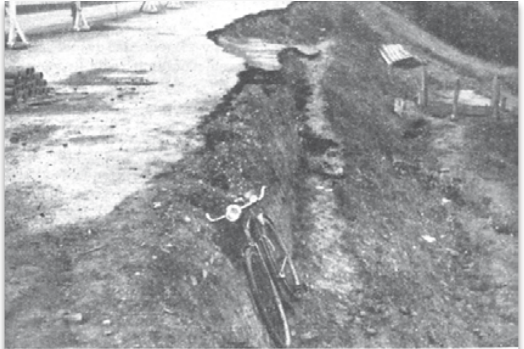
FIG. 1. — Glissement d'un remblai par suite d'un talus trop raide.
