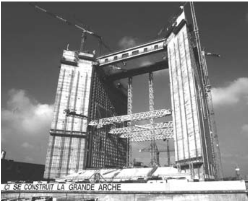
Une vue du chantier de la grande Arche : la mise en place du toit.
