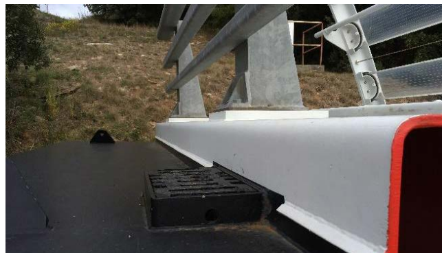
Maquette taille réelle des encorbellements, les zones en noir sont recouvertes d'enrobés sur le vrai viaduc aire du viaduc de Millau (12), 26/10/2020, B. Velty
