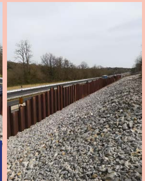
Rupture de crête et rideau de palplanches en cours de battage - 31/03/2021 - B. Velly
