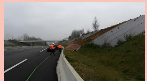
Glissement stabilisé durant l'inspection sécurité - 26/01/2022 - B. Velly
