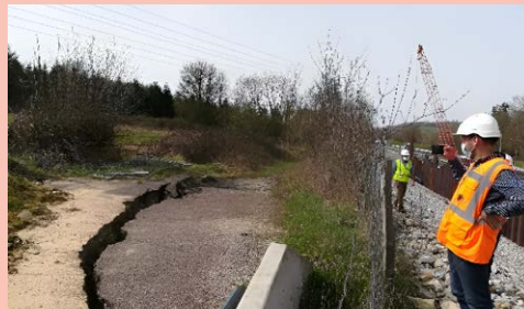
Rupture de crête et rideau de palplanches en cours de battage - 31/03/2021 - B. Velly
