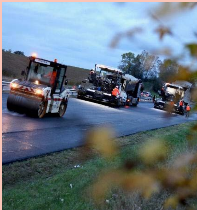
Expérimentation du liant Biophalt® sur A40 (APRR), sens 1, secteur de Vonnas (01), 26-30/10/2020, APRR
