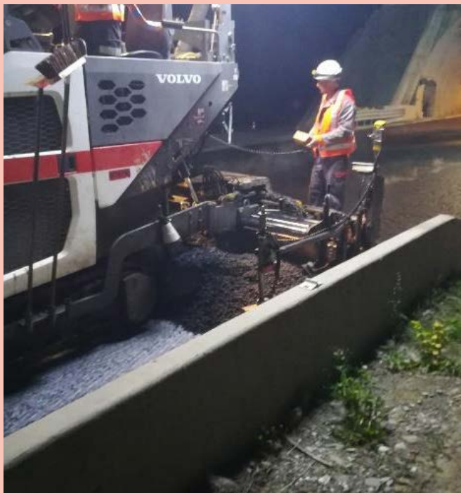
Expérimentation du liant Biophalt® sur RN205 (ATMB), tunnel des Houches, 18/09/2020, Bruno Velty
