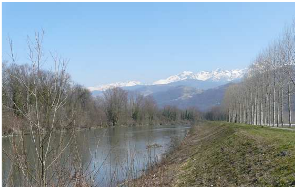
Digue à Grenoble © DREAL Rhône Alpes
