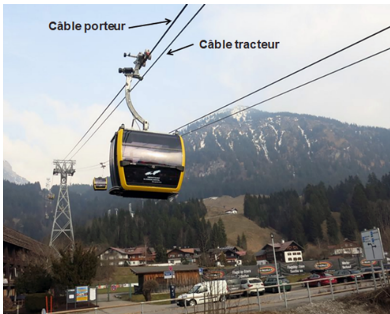
Téléphérique bicâbles 2S à Oberstdorf (Allemagne) © www.remontees-mecaniques.net .
