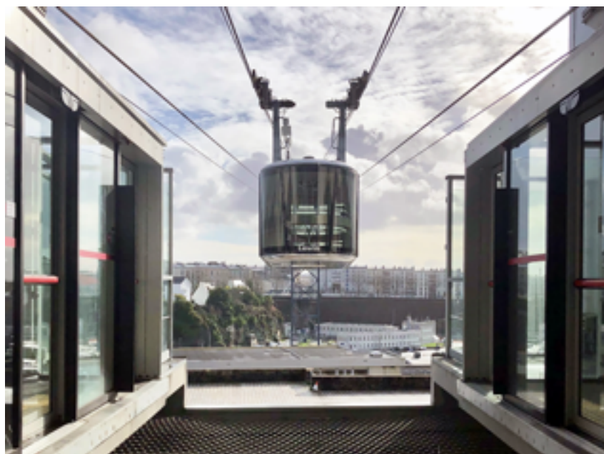
Portes palière quais du téléphérique de Brest ©RATP Dev.
