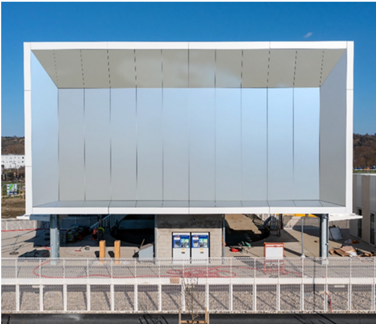
Station Oncopole : de plain-pied, elle est légèrement surélevée vis-à-vis des risques de crues de la zone. Les passerelles offrent un accès facilité à tous, avec un concept de station « ouverte » ©Tissé.
