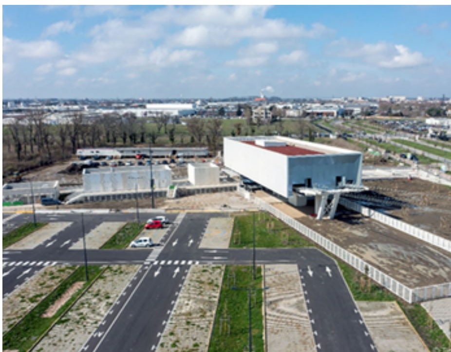
Station Oncopole de Téléo : dans cet espace peu dense, tous les accès sont de plain-pied. La zone étant toutefois inondable, la station est relevée au-dessus des plus hautes eaux connues. Des passerelles et rampes facilitent les accès depuis la voirie, mais aussi depuis le parking relais de 500 places enherbées. Les places PMR du parking sont situées en haut à gauche de la photo, au contact de la passerelle d'accès à la station. Elles sont réalisées en enrobés ©Tisséo.
