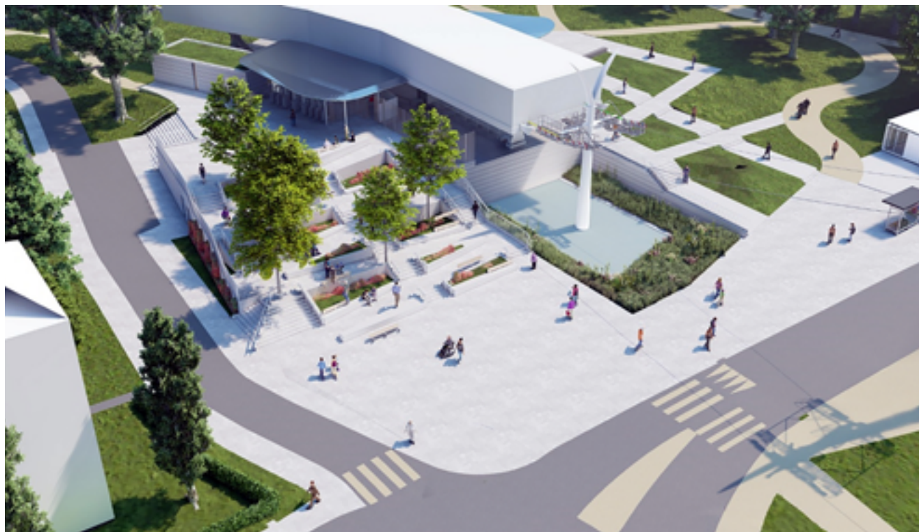
Câble 1 – Station Émile Zola présentant la vue globale du traitement des dénivelés pour accéder sans mécanisation à la station ©Île-de-France Mobilités.
