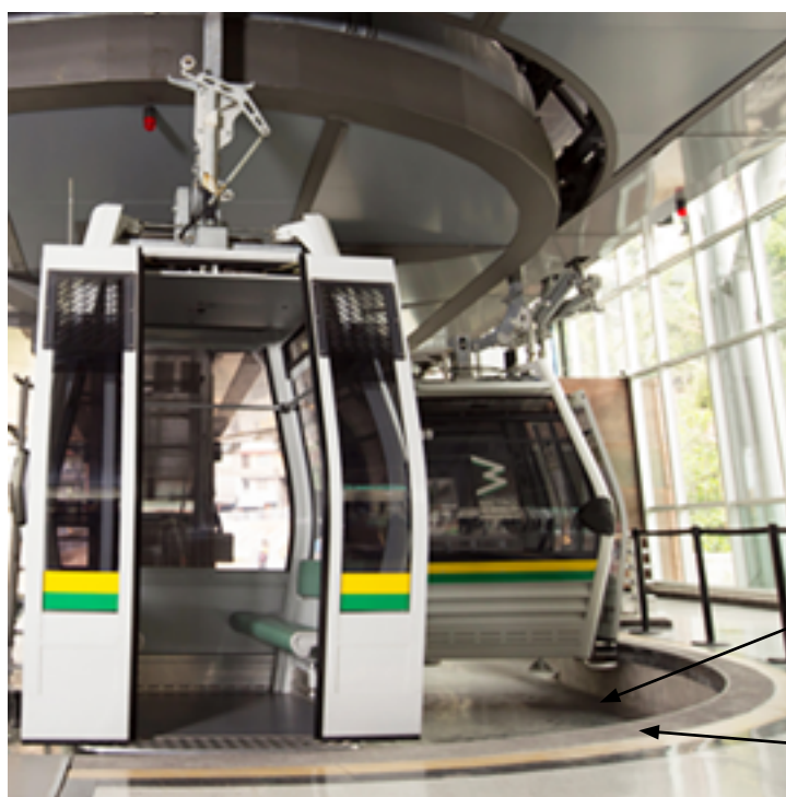
Fosse en station sous cabine à Medellin (Colombie) ©POMA.
