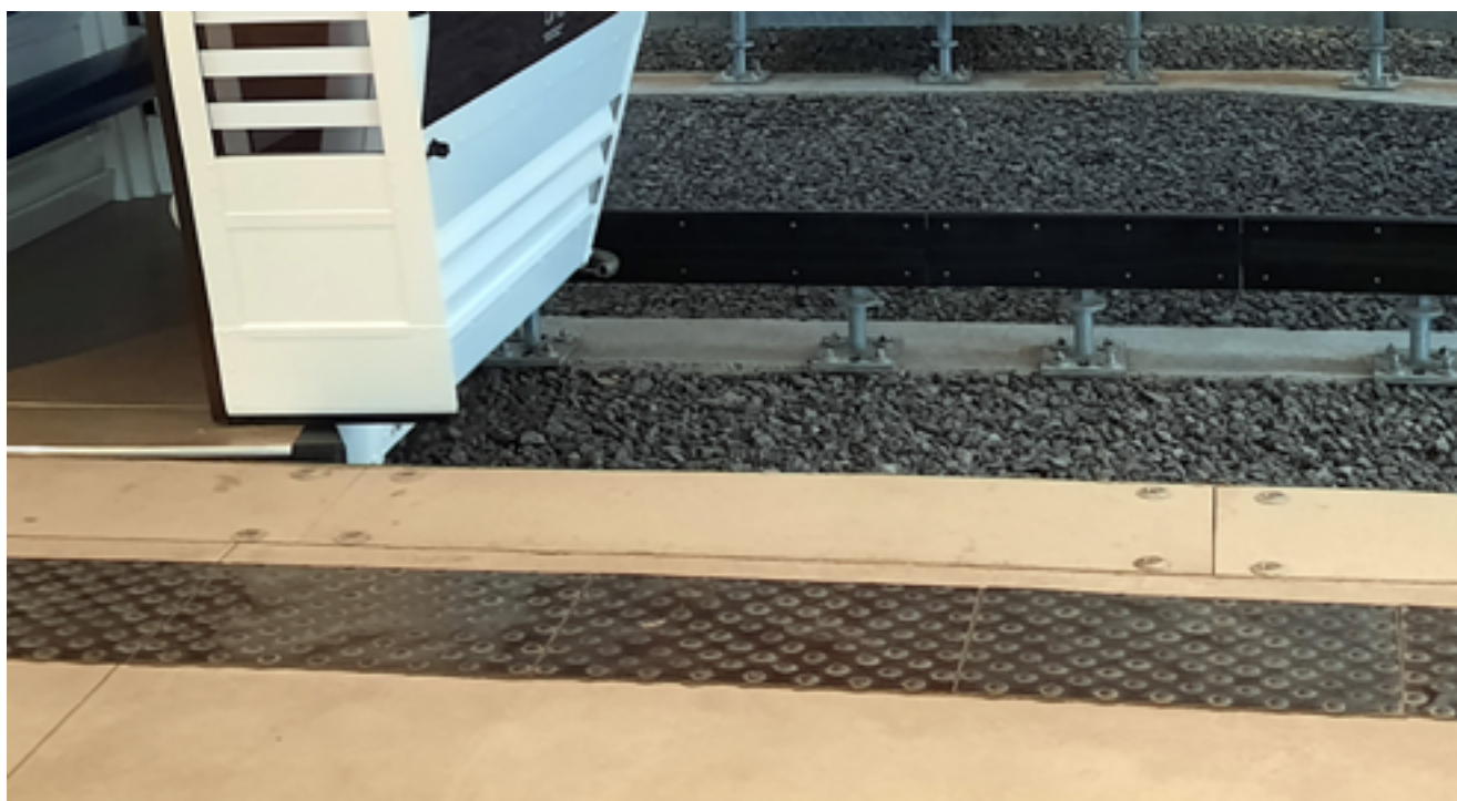
Bande d'éveil de vigilance sur un quai à Saint-Denis de la Réunion ©Papang.
