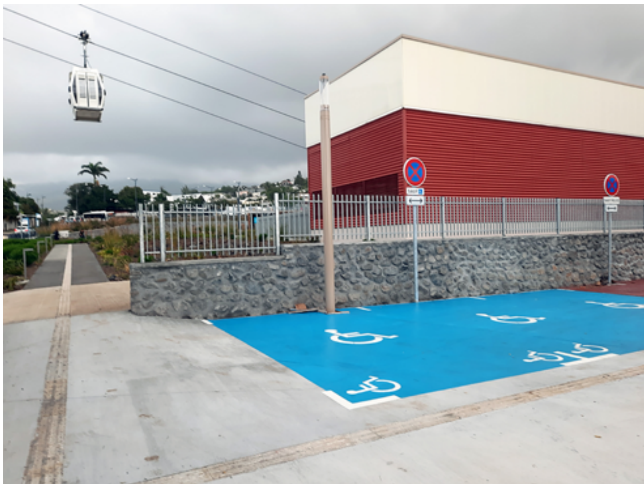
La Réunion, station disposant de deux places de stationnement PMR avec bande de guidage jusqu'à l'entrée de la station.
