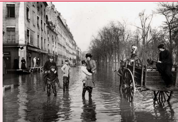
Rue de Bellechasse pendant la crue de janvier 1910 Guide PPRN 2016
