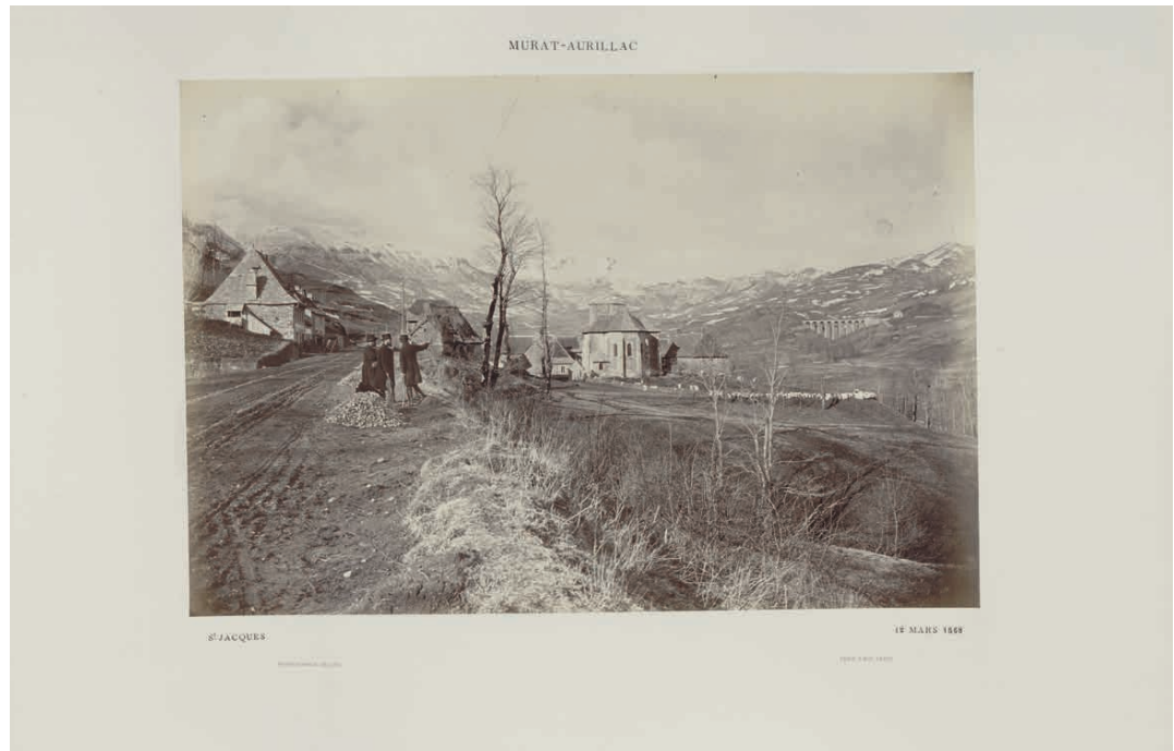
Saint-Jacques sur la ligne de Murat à Aurillac, discussion sur un tracé le 12 mars 1868 ©Ecole Nationale des Ponts et Chaussées PH 441 A.41
