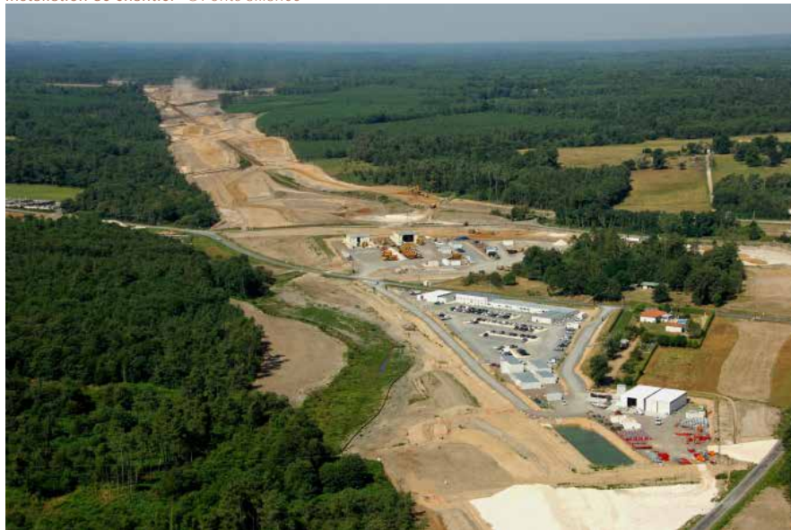
Installation de chantier ©Ponts alliance
