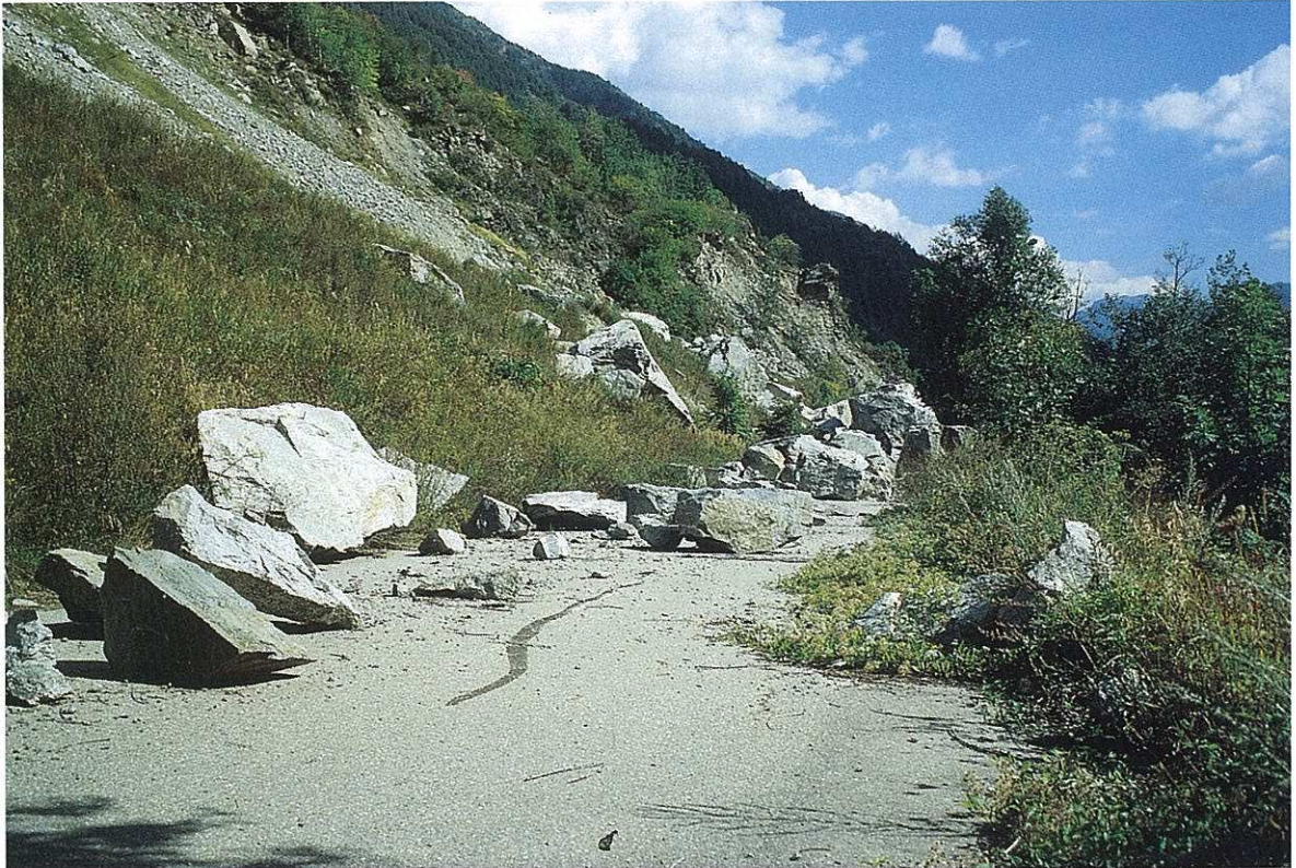
Photo 2. Chutes de blocs sur une route.
