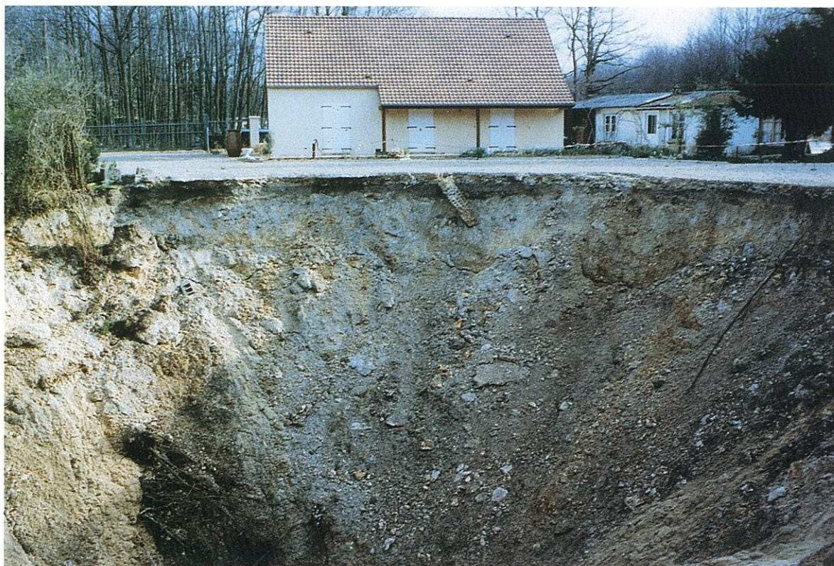
Photo 1. Exemple de fontis engendré par l'effondrement d'une carrière souterraine de gypse.
