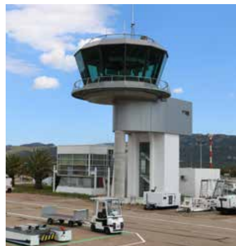
La nouvelle tour offre un environnement de travail plus performant aux contrôleurs aériens de Figari.
